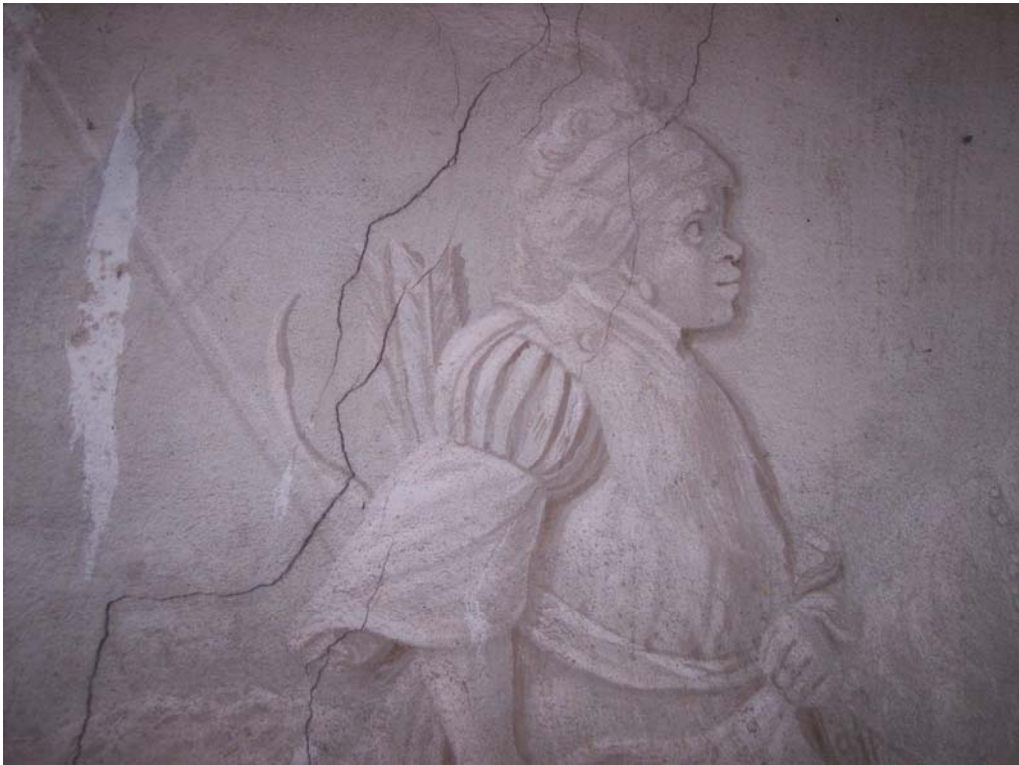
Scuderie, lunette, lesioni, distacchi di intonaco.
