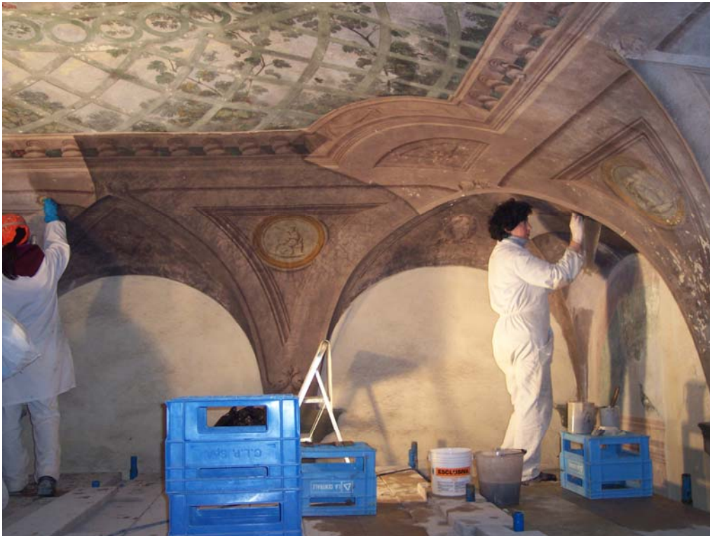
Sala pergolata, durante la pulitura, soffitto.
