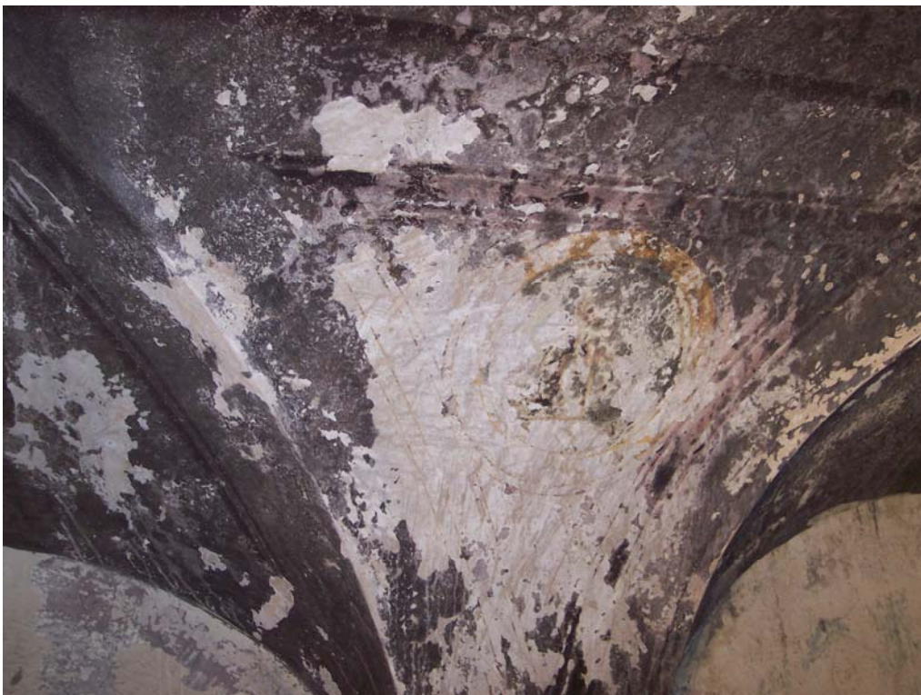
Sala pergolata, infiltrazioni gravi in una delle vele. Evidente il disegno preparatorio per la decorazione eseguito sul intonachino sottostante.
