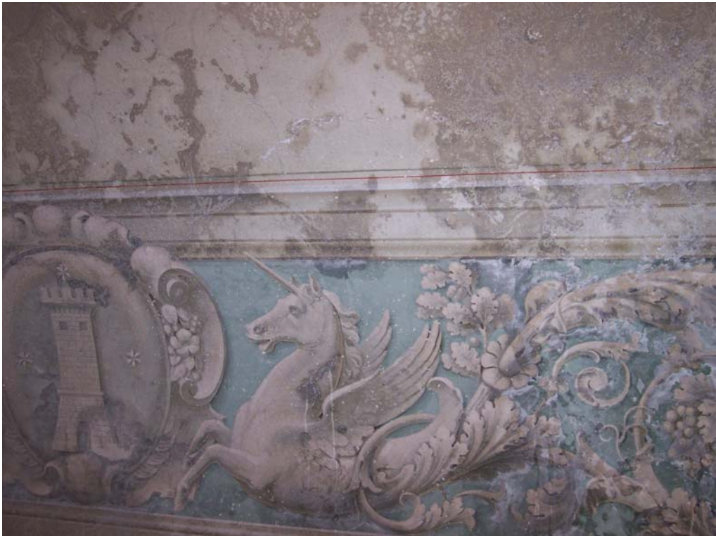
Salone, ossidazioni a causa di infiltrazioni.
