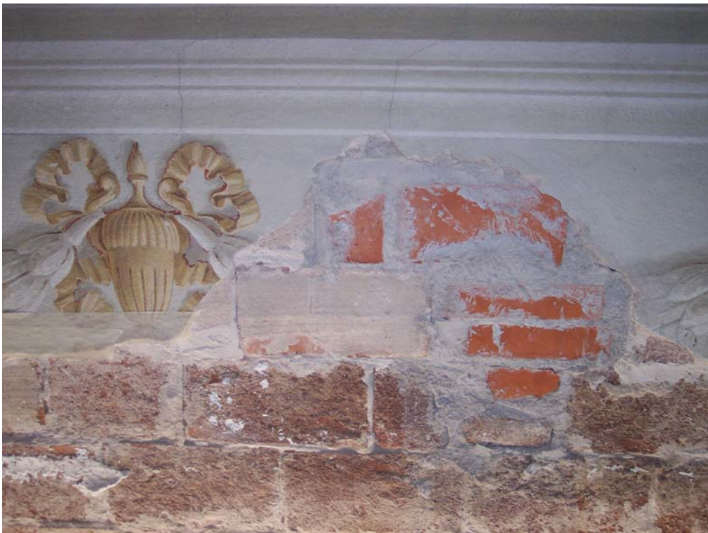
Salone principale , danni provocati dal controsoffitto, ora rimosso.
