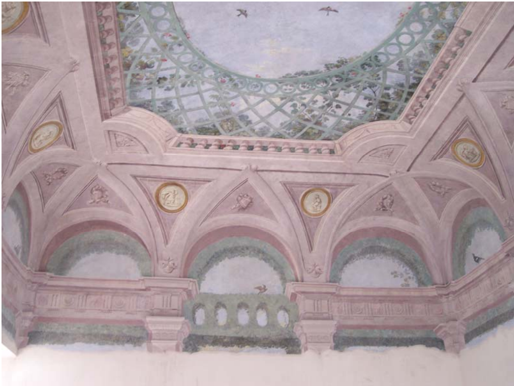
Sala pergolata, restauro completo.
