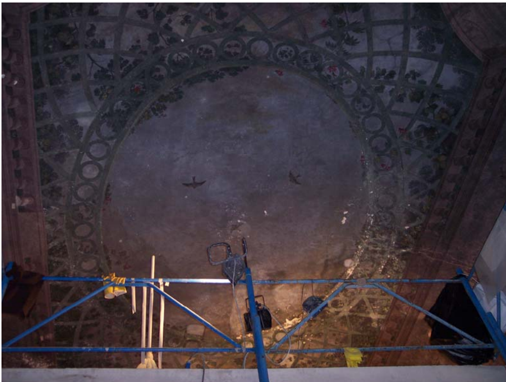
Sala pergolata, saggi e preconsolidamento.
