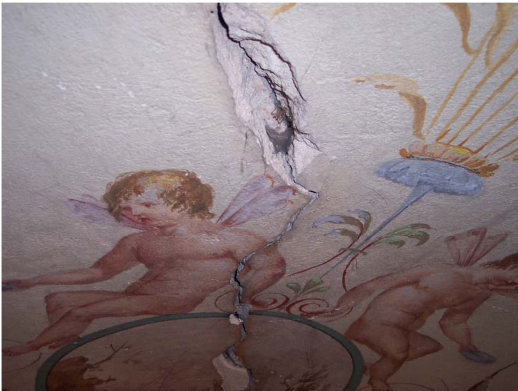
Salone, lesioni con cadute di intonaco.
